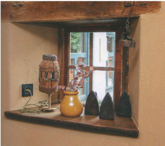
Detail im „Eifelspa“-Eingangsbereich. Die Innenwände wurden in traditioneller Lehmbauweise gebaut.
