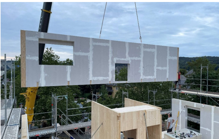
Auch das können sie bei Floss: Ein Wohnhaus in Trier um eineinhalb Geschosse aufstocken, alles im Holzbau. Foto: Floss Holzbau
