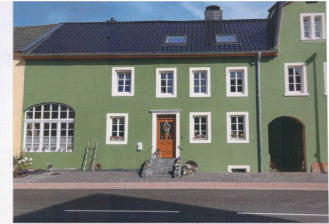
Moderne Sprossenfenster: Nach Kernsanierung ist dieses alte Bauernhaus in Pelm mit angrenzender Scheune ein echter Hingucker.
