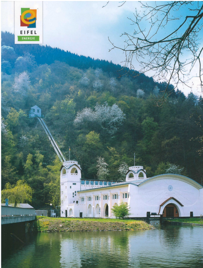
Links: Das Wasserkraftwerk Heimbach wird über einen Stollen aus der Urfttalsperre versorgt und liefert mit den Wasserkraftwerken der Rurtalsperre den „grünen“ EIFEL Strom.
