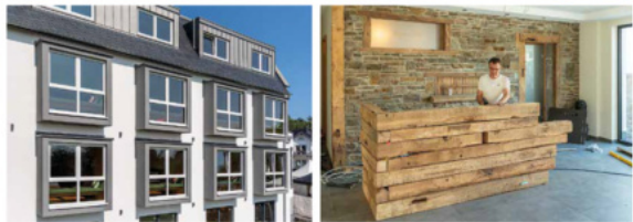
Der Erweiterungsbau (unten links) bietet auf rund 300 Quadratmetern Platz für zwölf weitere Zimmer, drei Ferienapartments, einen Wellnessbereich und den lichtdurchfluteten Follabubaraum (oben). Im Bereich der neuen Rezeption (unten rechts) finden sich alte Balken und Steine aus der abgerissenen Scheune wieder.
