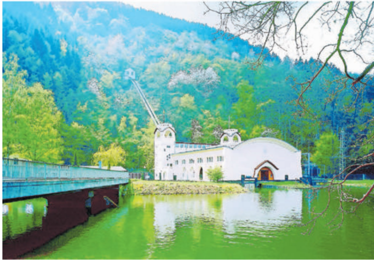
Die Eifel ist schon lange Vorreiter, wenn es um das Thema „erneuerbare Energien“ geht - wie etwa bei der Wasserkraft mit dem Wasserkraftwerk Heimbach.
