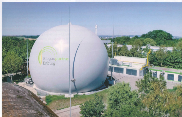
Der Biogas-Speicher auf dem Bitburger Flugplatz.
