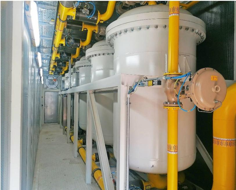
Das Herzstück: In diesen Reaktoren wird aus dem Rohbiogas Erdgas gewonnen. Das funktioniert per Druckentspannung. Foto: Nils Straßel
