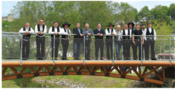
"Belastungstest" durch die Mitarbeiter der Firma Floss: Die Holzbrücke verfügt über ein Knotenpunktsystem aus einem speziellen Polymerbeton.
