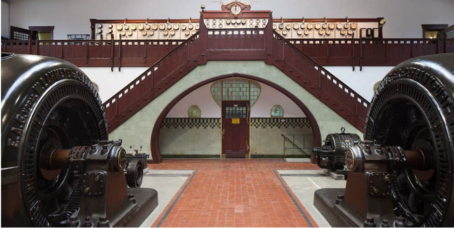
Das Heimbacher Jugendstilkraftwerk erzeugt jährlich 25 Millionen Kilowattstunden Strom. (Bildarchiv Foto Marburg/Andreas Lechtape)
