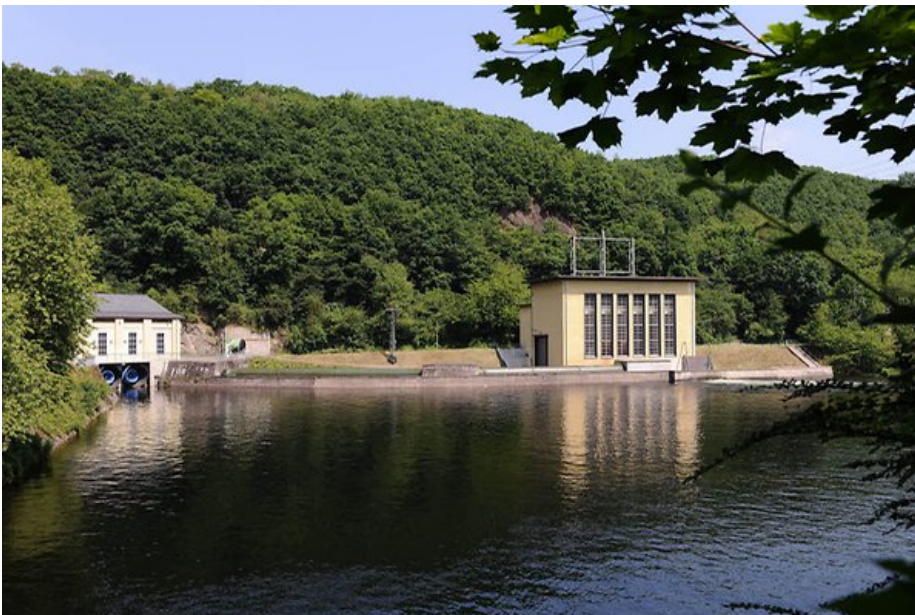
Auch im Kraftwerk Schwammenauel wird kontinuierlich Eifelstrom aus der Rurtalsperre gewonnen. (Foto: RWE International SE)
