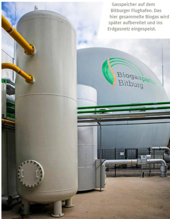
Gasspeicher auf dem Bitburger Flughafen. Das hier gesammelte Biogas wird später aufbereitet und ins Erdgasnetz eingespeist.
